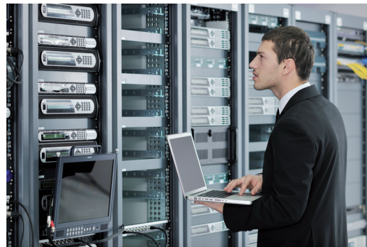
W serwerowni In server room (fot. photo Fotolia)
