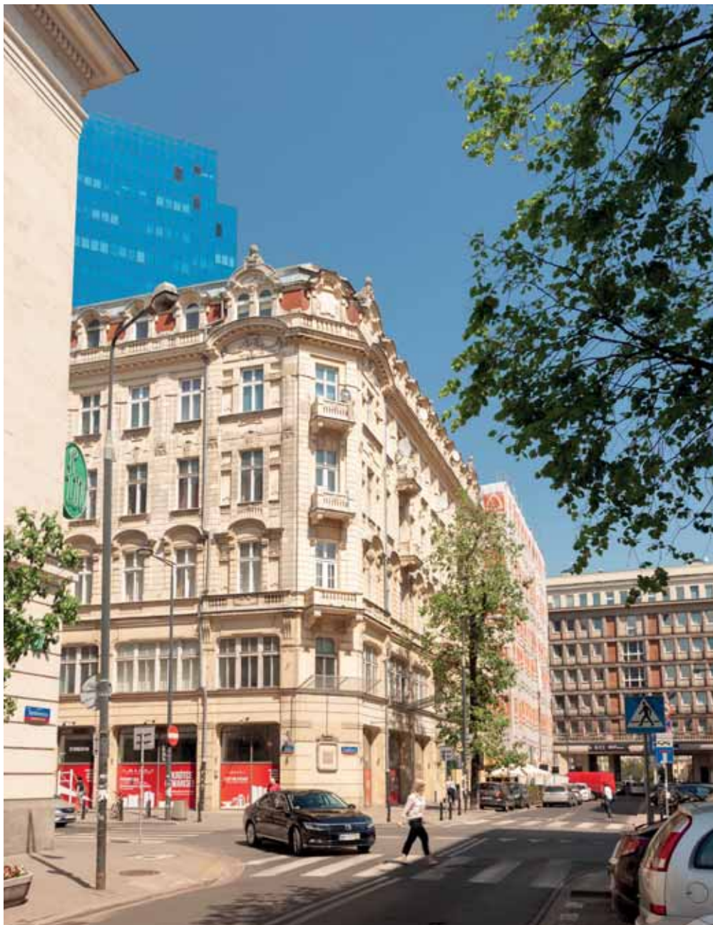
ul. Jasna 10 w Warszawie 10, Jasna Street in Warsaw
